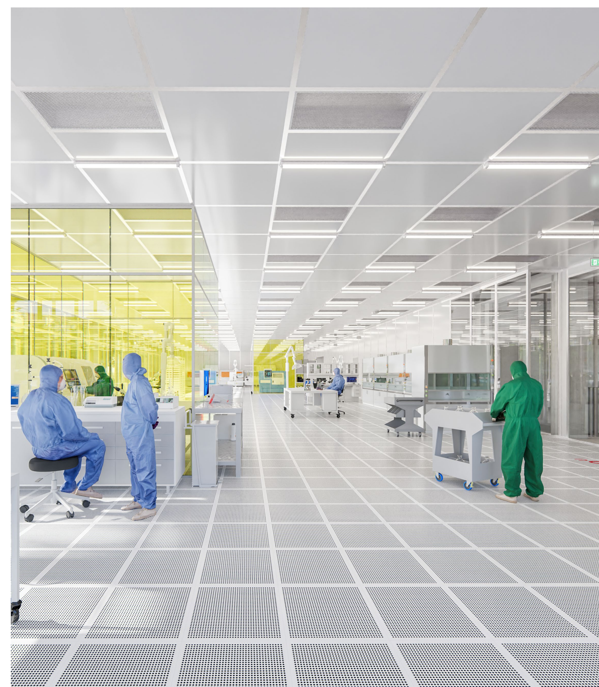
Bygningen har kapacitet til at rumme 900 m 2 renrum under filter
