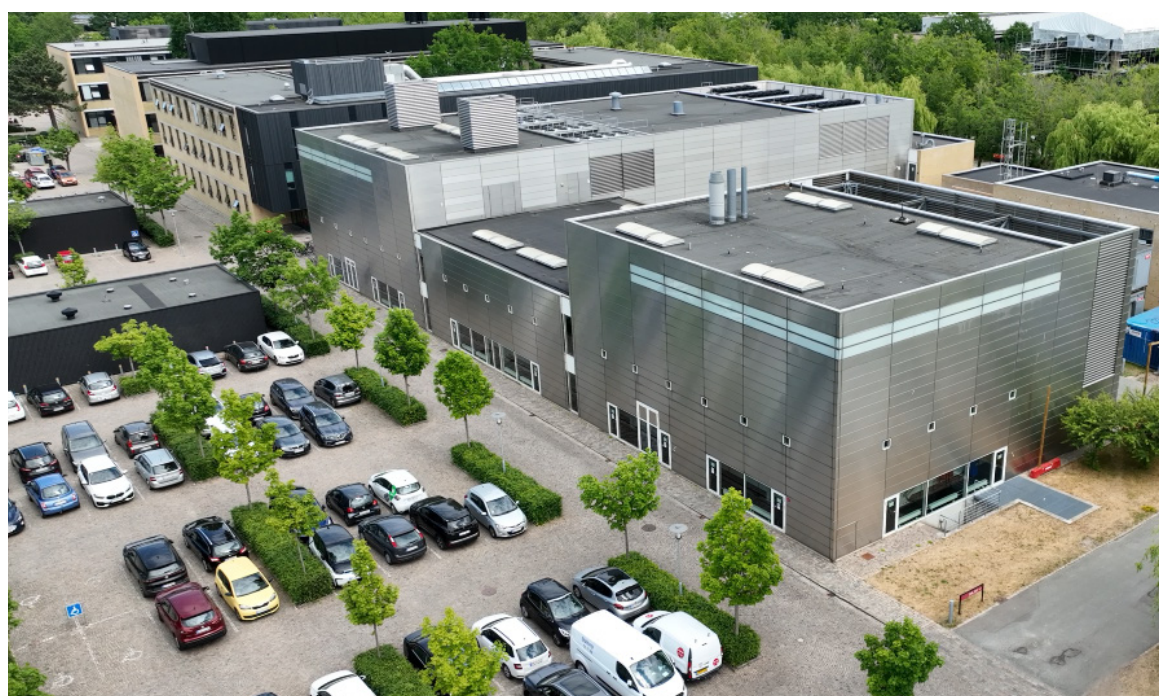
B346A opføres på Ørstedes Plads. Nanolab Phase 4 bliver opført på Ørstedes Plads på DTU Lyngby Campus og kobles sammen med det eksisterende renrum, så der skabes en samlet facilitet. Foto: DTU
