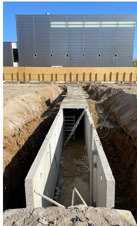
Tunnelsystemet under DTU er mere end 50 år gammelt og er en livsnerve i forhold til forsyning på Lyngby Campus. En del af forberedelserne til byggepladsen på Ørstedes Plads er at fjerne et stykke af den gamle tunnel - og bygge en ny tunnel.
